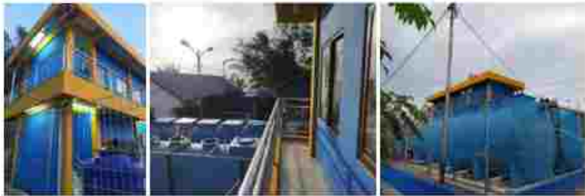
Gambar 3.2 Pembangunan SPALD-T di Pulau Kelapa Dua (Sumber: Dokumentasi Suku Dinas Sumber Daya Air Kab. Adm. Kepulauan Seribu)
