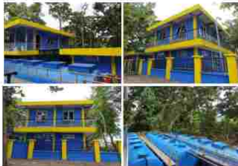
Gambar 3.3 Pembangunan SPALD-T di Pulau Sabira (Sumber: Dokumentasi Suku Dinas Sumber Daya Air Kab. Adm. Kepulauan Seribu)
